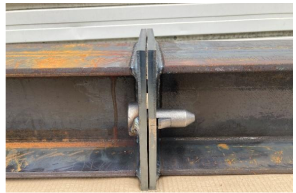
〈支保工連結状況〉
